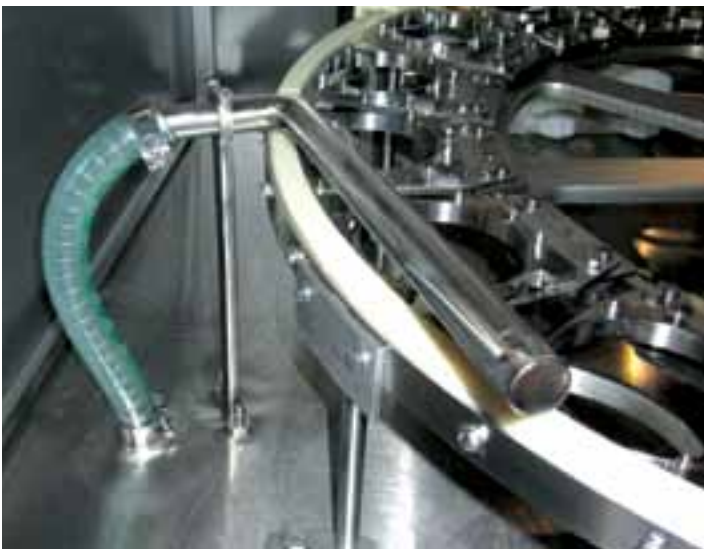
Vorrichtung für die Luftentkeimung im Karussellfüller
